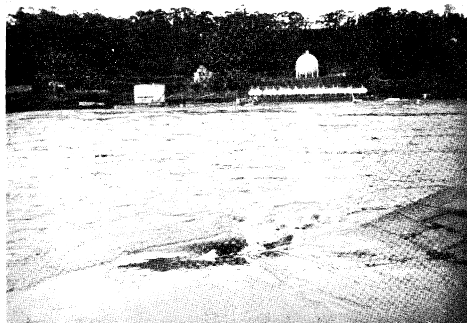
EST. II, A — O depósito e cais da Mobil, na margem esquerda do Douro (1 de Março de 1978). A estrada marginal está coberta por 2 metros de água.
