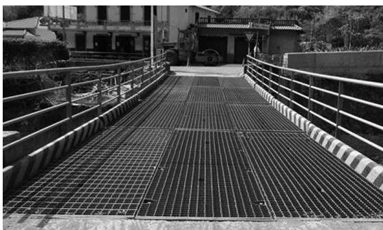
Figura 4 - Ponte Treadway montada em 2011 sobre a Ribeira Brava, Madeira (EPE, 2015)
