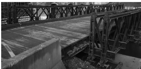
Figura 5 - Ponte Bailey montada em Ferreira do Alentejo (EPE, 2015)
