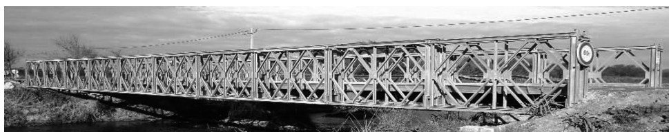
Figura 1 - Ponte Mabey montada em Mira [Fonte própria]
