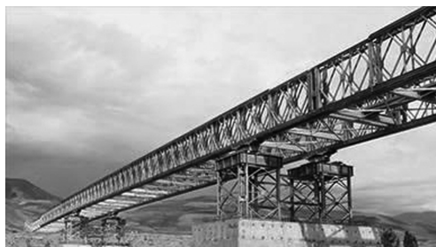
Figura 7 - Ponte Mabey com apoios intermédios (MBL, 2014b)
