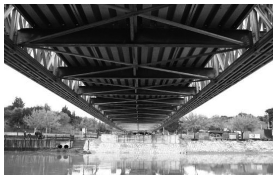
Figura 17 - Vista inferior do travamento em planta do tabuleiro montado em Odemira (EPE, 2015)
