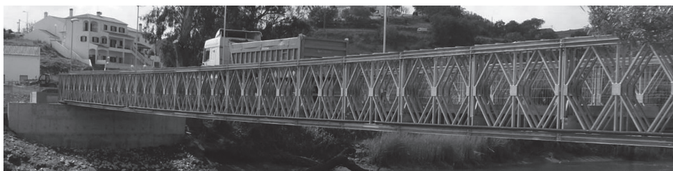
Figura 22 - Ensaio de carga na ponte Mabey montada em Odemira (EPE, 2015)
