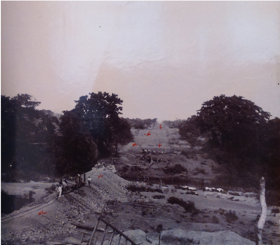
5 Traçado no rio Umbeluzi: a) passagem provisória; b) restabelecimento de traçado; c) não identificado; d) ponto atingido pelo rio nas chuvas anteriores
