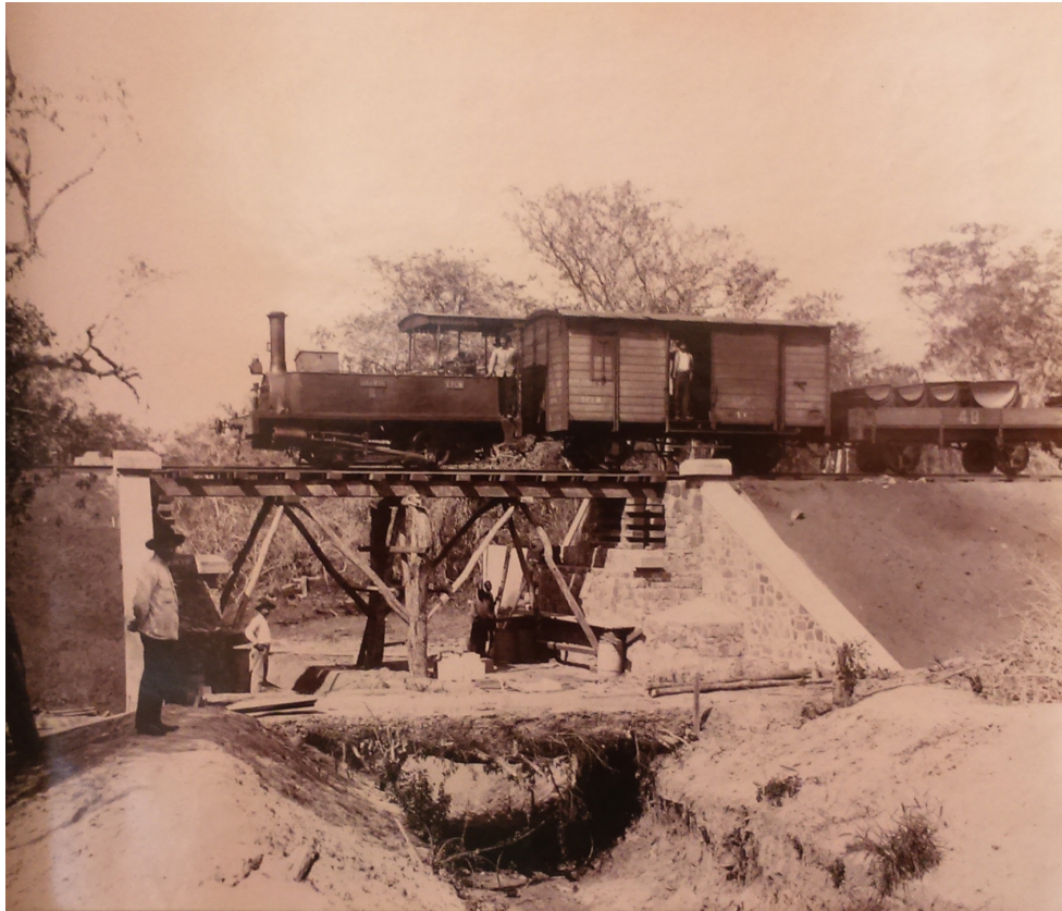
4 Comboio sobre ponte
