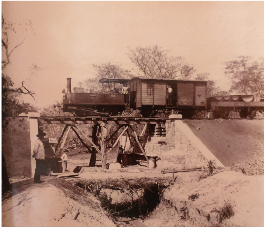
4 Comboio sobre ponte
