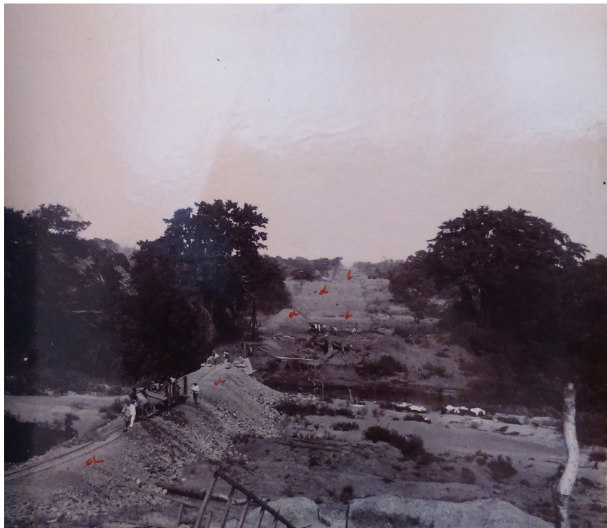
5 Traçado no rio Umbeluzi: a) passagem provisória; b) restabelecimento de traçado; c) não identificado; d) ponto atingido pelo rio nas chuvas anteriores
