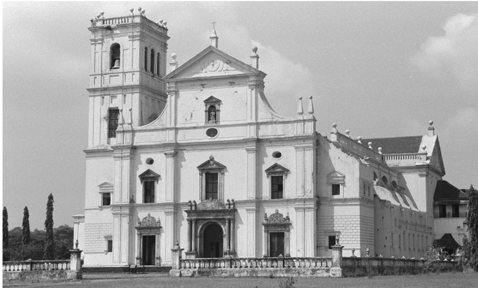
Fig. 8 – Velha Goa, Sé de Goa: fachada (1996).
