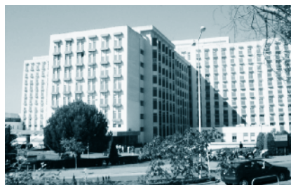
Figura 3 – Imagem do novo edifício central dos HUC.
