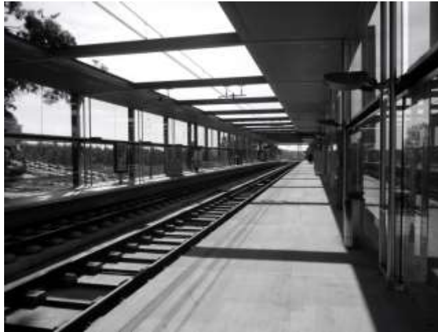
Figura 7. Estação “Parque da Maia” (Arq. João Álvaro Rocha).
