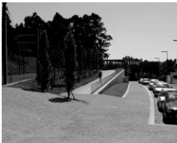
Figura 3. Estação “Parque da Maia” (Arq. João Álvaro Rocha).
