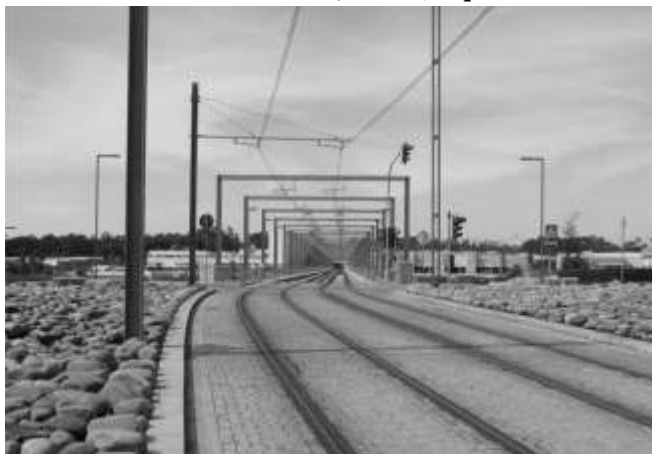
Figura 4. Viaduto Zona Industrial, Maia (Arq. João Álvaro Rocha).
