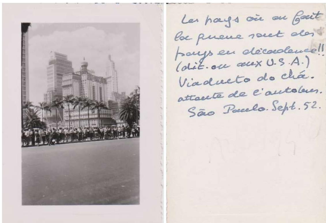
Figura 19. Fila para o autocarro, Viaduto do Chá, set. 1952
