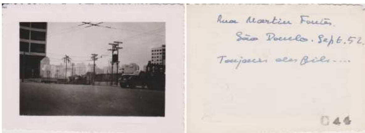
Figura 27. Fiação aérea, Rua Martins Fontes x Rua da Consolação
