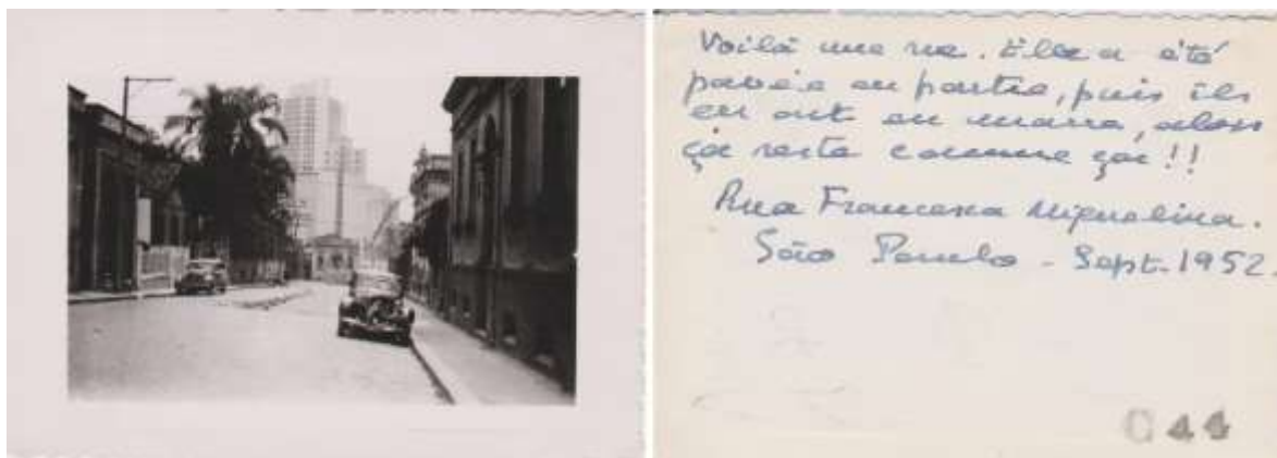
Figura 24. Precariedade do calçamento, Bela Vista
