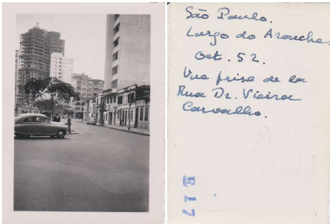
Figura 17. Contraste entre velhas e novas construções, Largo do Arouche
