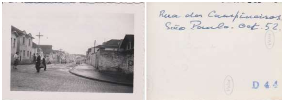
Figura 11. Rua dos Campineiros, Mooca
