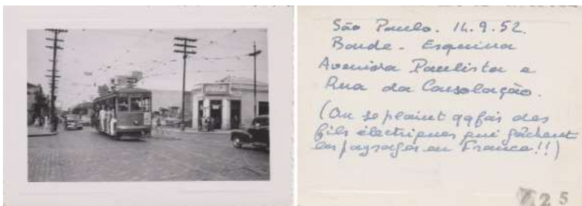
Figura 28. Postes e fiação aérea, Rua da Consolação x Avenida Paulista
