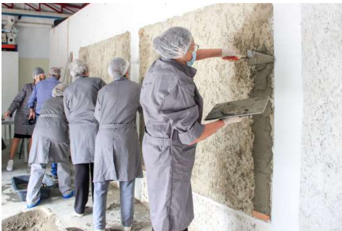
Figura 3. Aplicação de massa em parede
