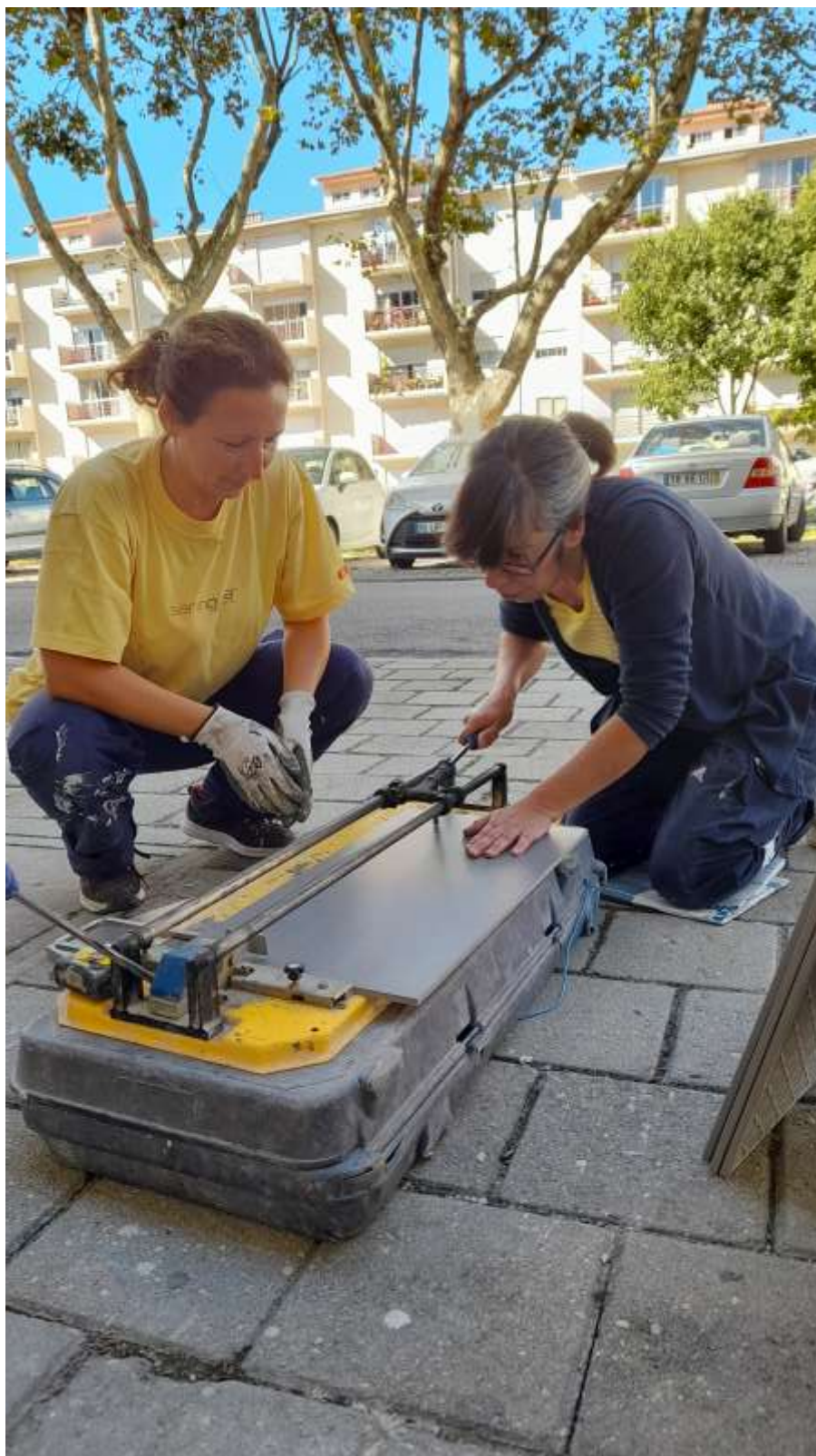
Figura 5. Obra de remodelação do espaço para o Banco Comunitário de Materiais e Ferramentas
