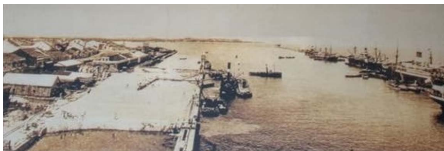
Figura 2. Aterros para a construção do Porto, 1910
