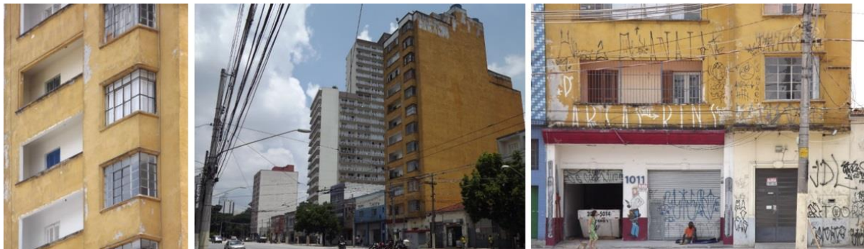
Figura 4. Exemplo de edifício em área de ZEIS.
