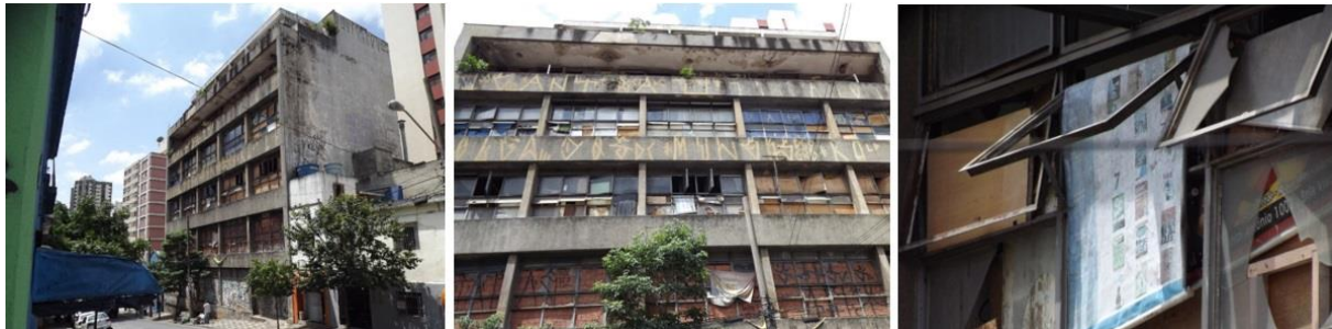
Figura 3. Exemplo de edifício em processo de desapropriação.
