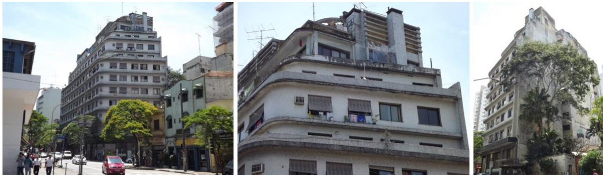
Figura 2. Exemplo de edifício desapropriado.
