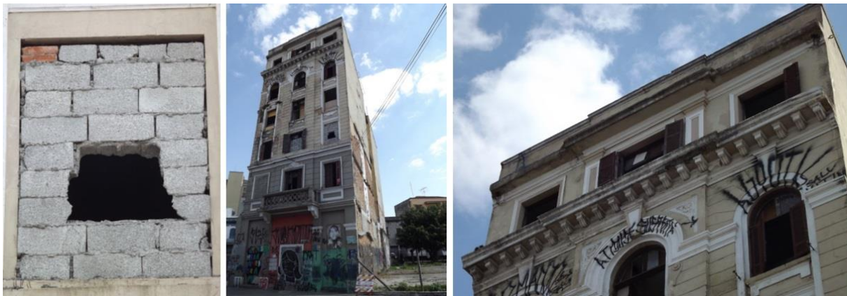
Figura 6. Exemplo de edifício ocioso.
