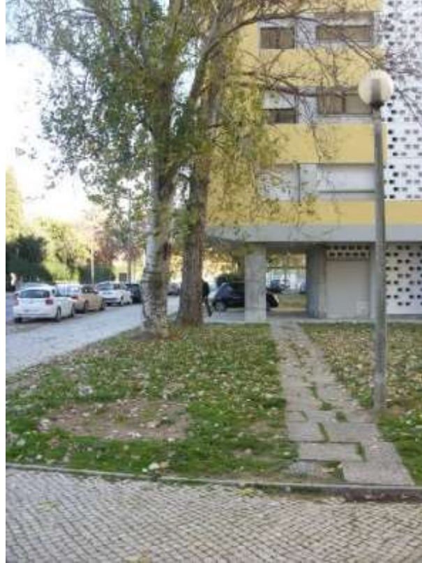
Figura 20a. Conjunto Habitacional do Montepio Geral, na Av. do Brasil.
