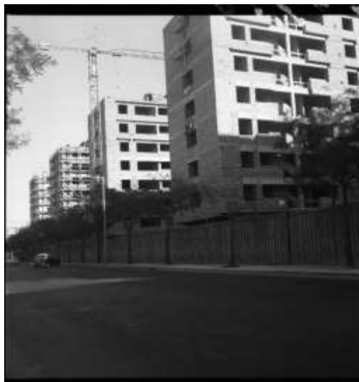
Figura 18a. Construção do Conjunto Habitacional do Montepio Geral (1961).
