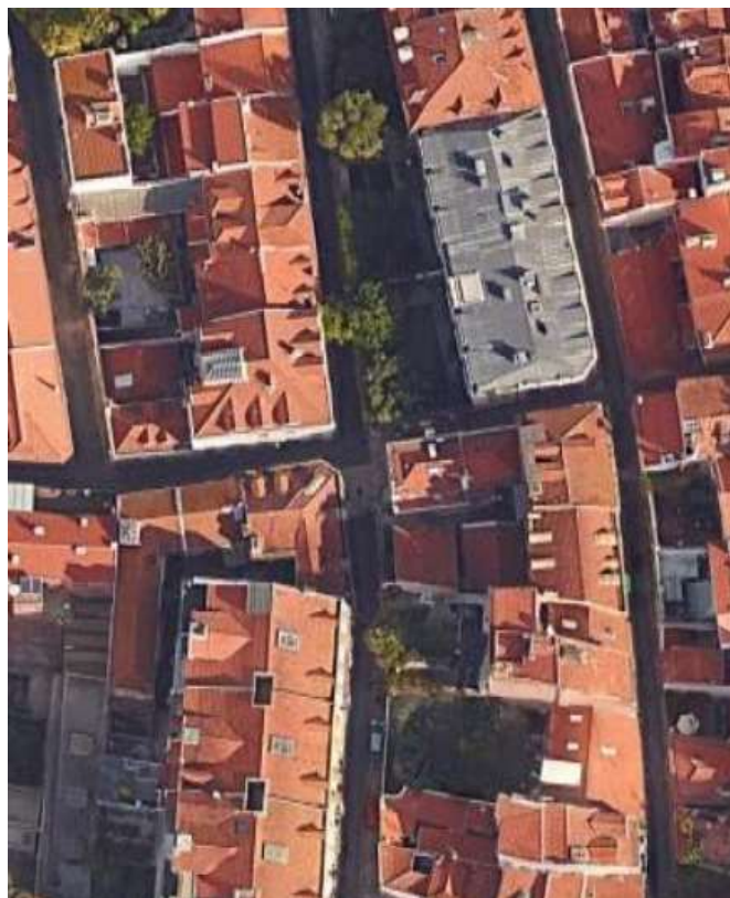
Figura 1. Localização do edifício em foto recente de satélite
