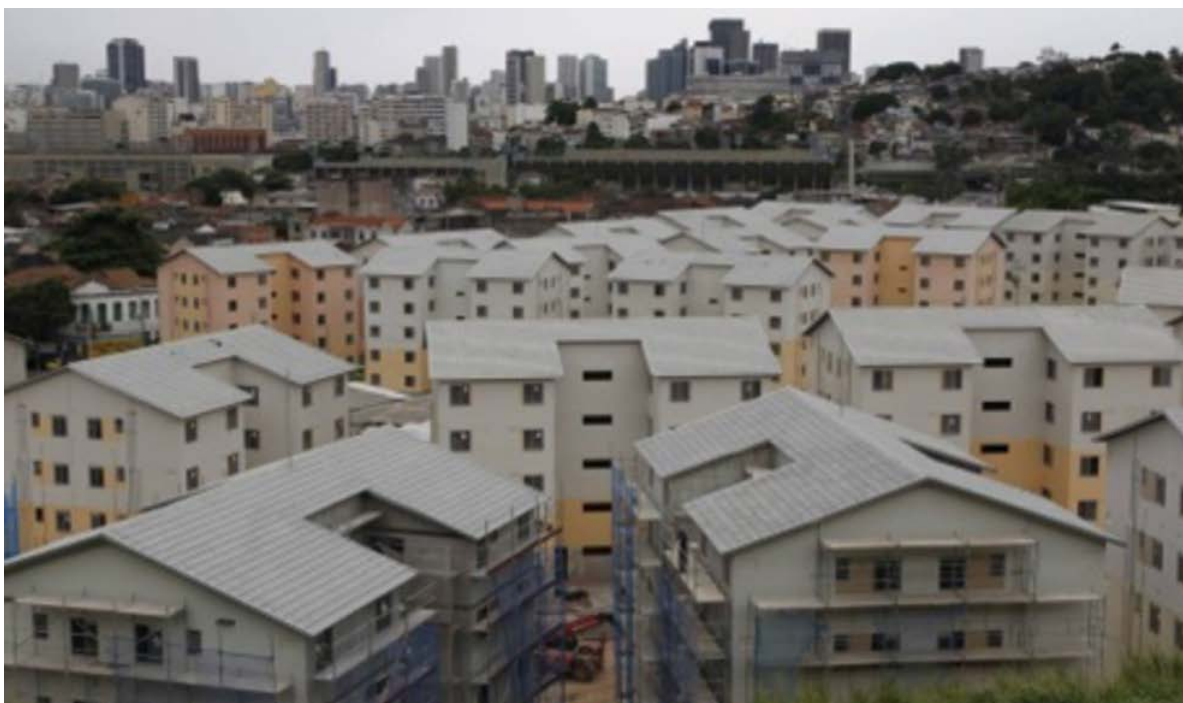
Figure 4. 'Minha Casa, Minha Vida' under construction
