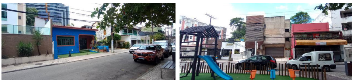
Figura 7. Edificações sem uso: a) Lado A; b) Lado B
