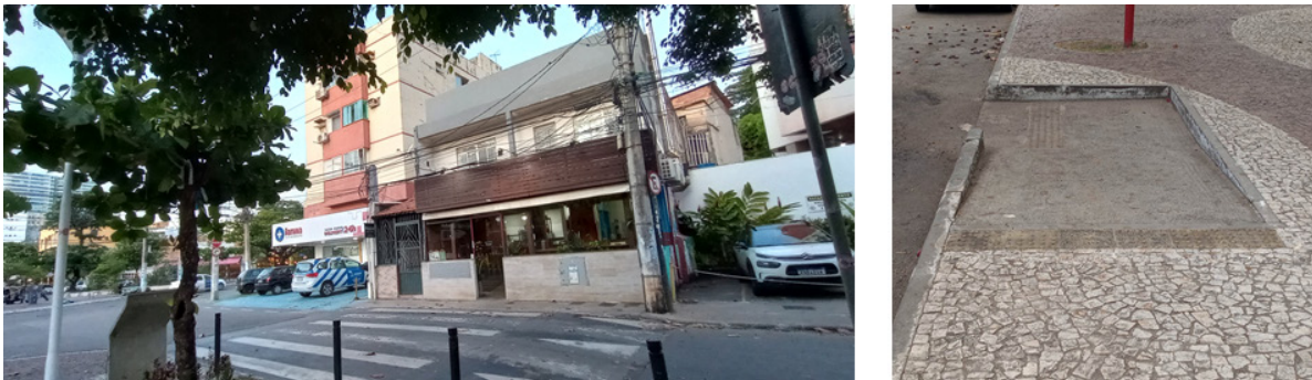
Figura 12. Travessias: a) Faixa elevada; b) Rampa no canteiro central
