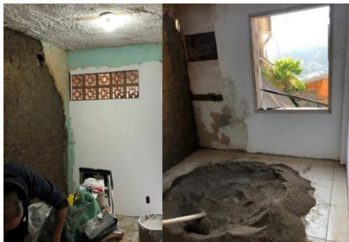
Figura 12. Canteiro de obras e inserção de vão de ventilação entre divisões
