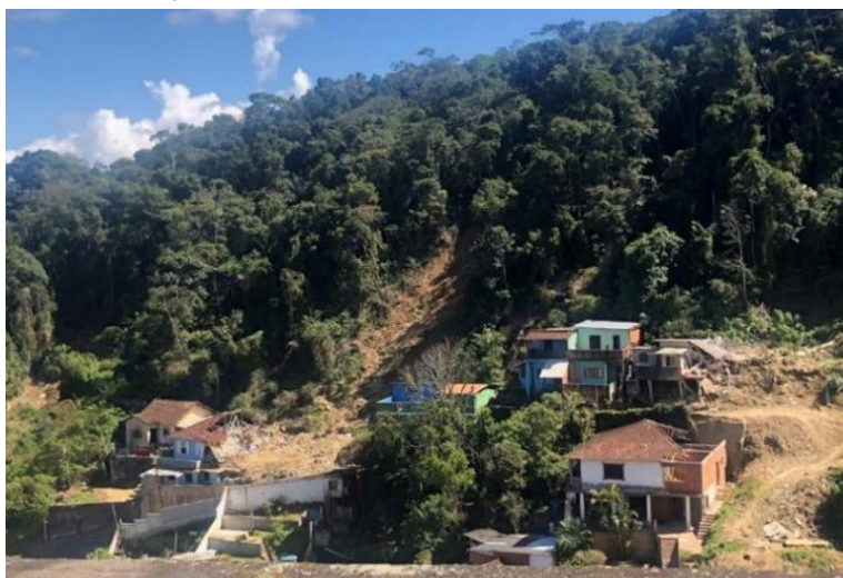
Figura 7. Casa em área de risco sendo reformada
