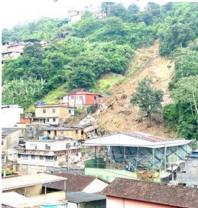
Figura 9. Deslizamento na quadra
