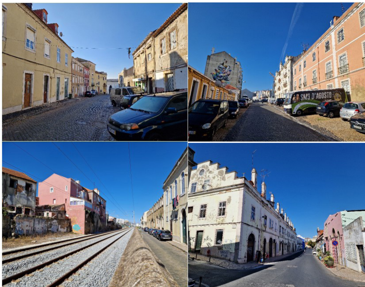
Figura 4. O estoque edificado à espera
