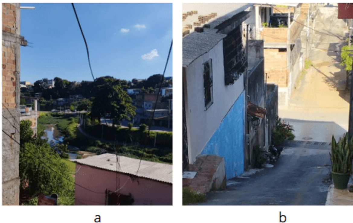
Figura 5. Exemplos do planejamento equivocado nas obras
