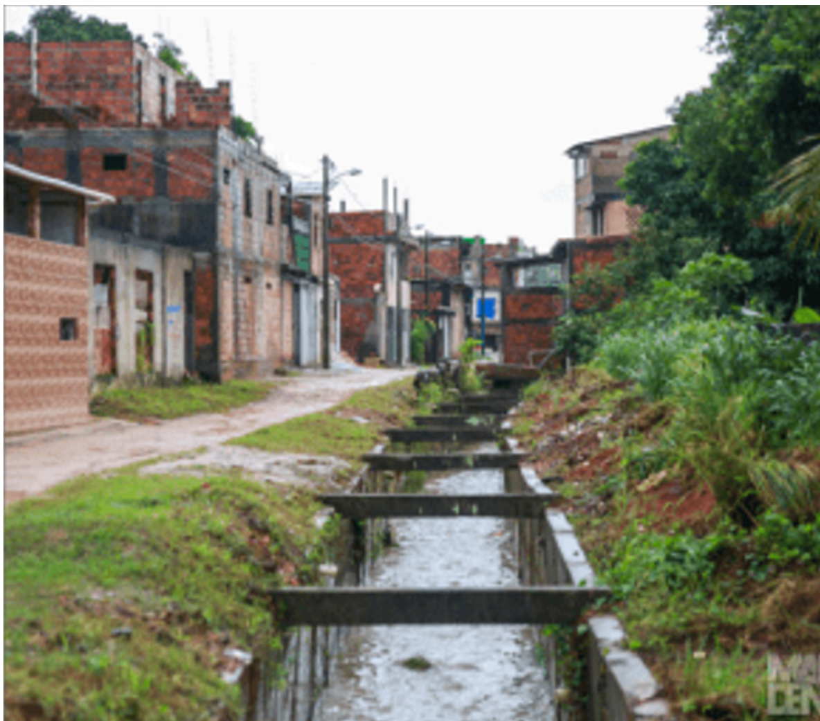
Figura 3. Saneamento básico deficitário antes da obra
