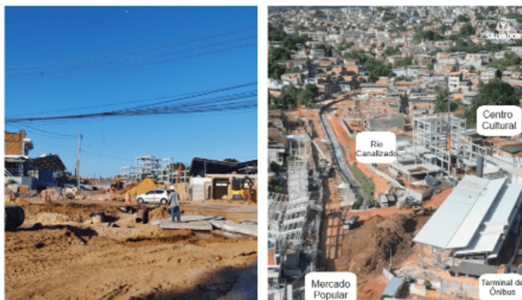
Figura 6. Obra do Terminal de Ônibus do Mané Dendê
