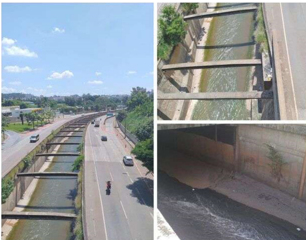
Figura 8. Fotos do canal aberto nos trechos 4, na Avenida Tereza Cristina, e 6, na Avenida Presidente Juscelino Kubitschek em Belo Horizonte
