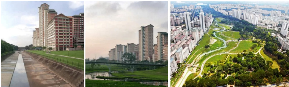
Figura 5. Intervenção de bioengenharia no rio Kallang na área do parque Bishan Ang Mo Kio, em Singapura, evidenciando o processo de descanalização e a integração entre drenagem urbana, paisagem e espaço público
