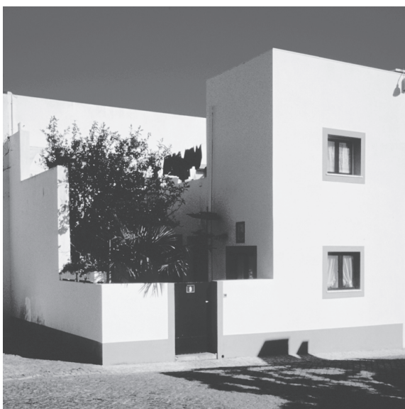
Casa de esquina com pátio de muro baixo (1,50 m). Foto de Jean-Michel Léger
