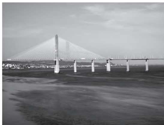
Figura 5 - Ponte Vasco da Gama
