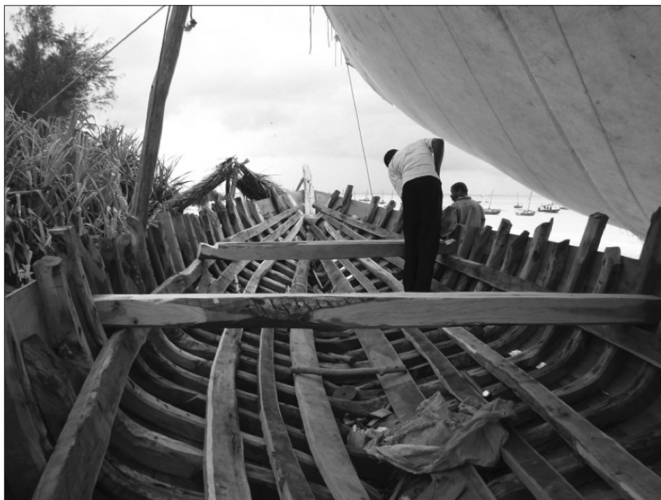
Figura 3: Construção de um dhow no estaleiro de Nungwi: cavname primeiro, pranchas depois
