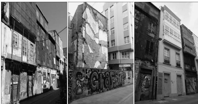
Fig. 2 – Diferentes ejemplos de edificios deteriorados en la calle del Orzán. Figura en color disponible en línea.
