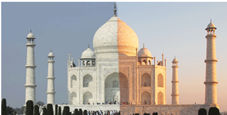
Fig. 2 – Taj Mahal: comparação entre a coloração original do Mármore (esquerda) e a cor atual (direita) devido a efeitos da poluição atmosférica. Figura a cores disponível online.
