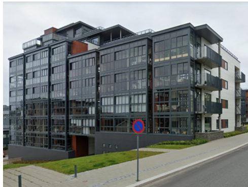
Fig. 2 – Bloco de apartamentos com varandas/marquises reversíveis. Figura a cores disponível online.
