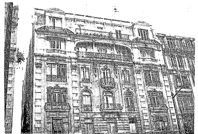
Est. 21 — Prédio na Rua Braancamp, Lisboa
