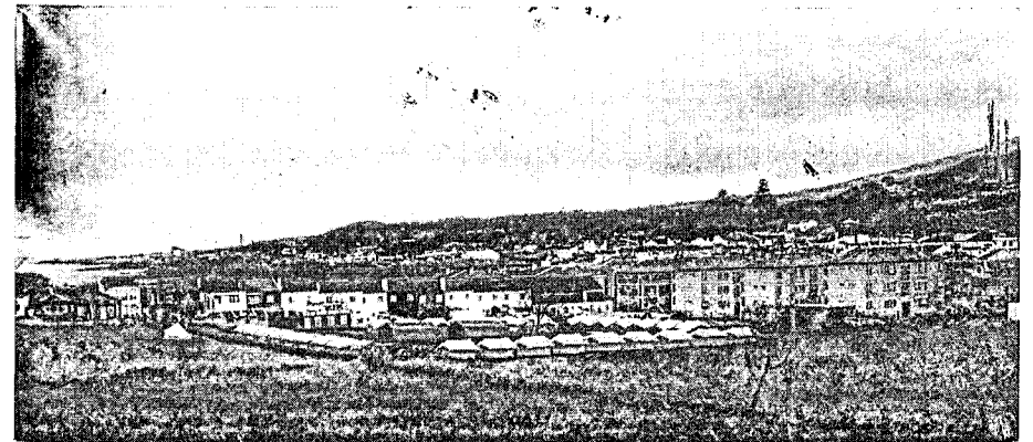
EST. II, B — Angra do Heroísmo. O primeiro acampamento para albergar os sinistrados. Em segundo plano, um bairro habitacional de construção recente, em perfeito estado de conservação.
