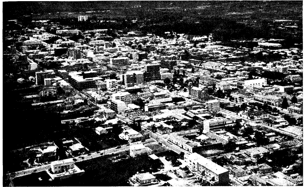
EST. V, A — Vista geral de Sá da Bandeira.
