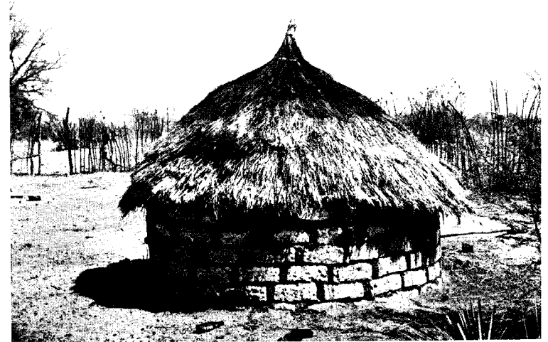
EST. VII, B -- Vista parcial de um eumbo novo, de monógano. Dois pormenores importantes, indicando alterações: a cerca é mais simbólica que verdadeira, formada por ramos frágeis; na casa empregou-se o adobe para substituir o baixo pé direito de paus-a-pique; comparar com as casas das fotografias III, B e IV, A e B; as dimensões são aproximadamente as mesmas.
