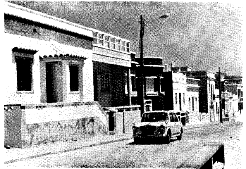
EST. VI, A --- Casas de veraneantes, da rua D. Francisco de Almeida, a sul do Largo da Igreja.
