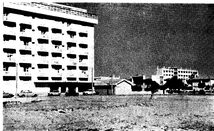
EST. VIII, A — Na área oriental esboça-se um novo centro, junto do qual se situam alguns grandes hotéis que se levantam dum conjunto de vivendas térreas ou de primeiro andar.
