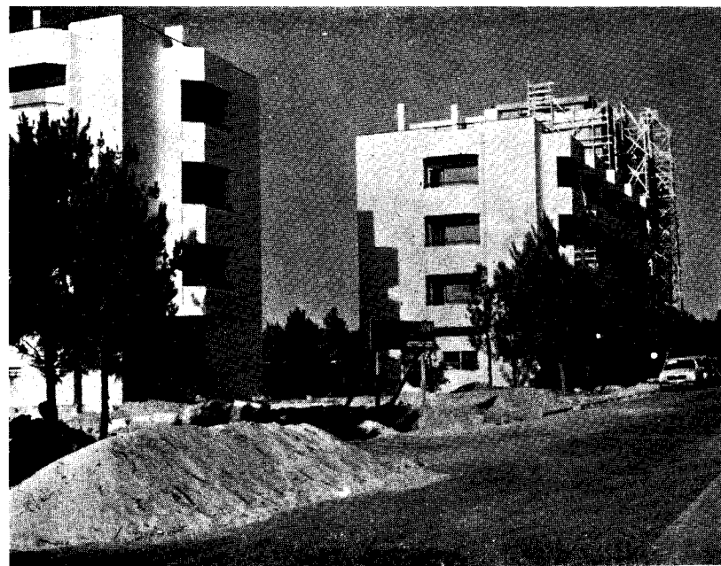
EST. VIII, B — A nascente, o avanço da frente de construções sobre o pinhal faz-se com edifícios de vários andares: no primeiro plano, os apartamentos da residencial Monte Sol; no segundo, as obras do novo hotel Alcazar.
