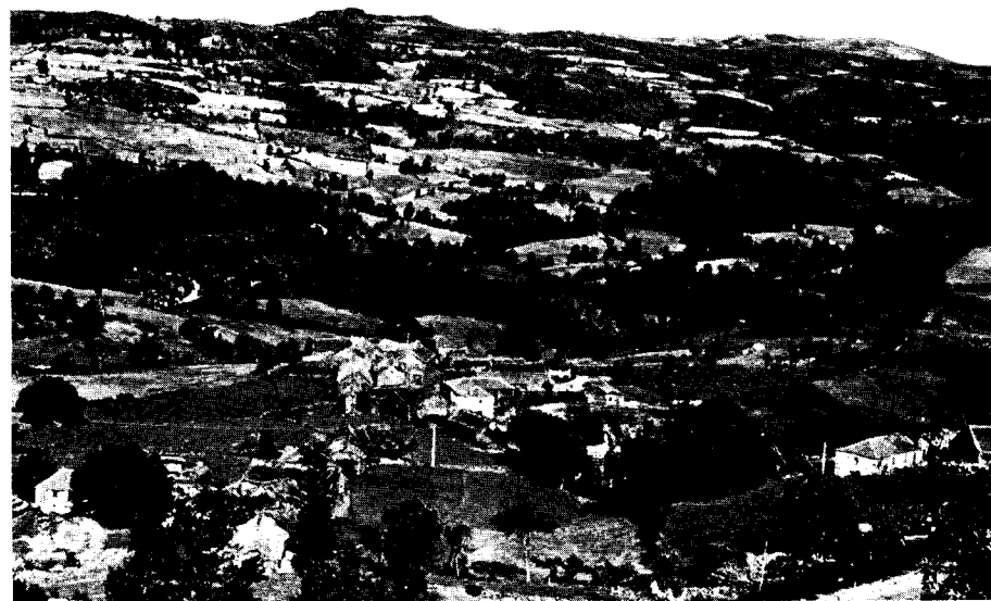
Pl. II, A — Vue générale du finage de Vilaça tirée du Sud.
