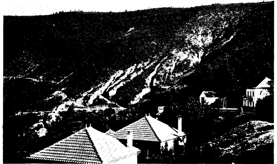
PL. VIII, A — Vue générale du versant de rive gauche du Rio Ceira à Porto da Balsa. Versant réglé encore largement nappé de géliфраacts. Ravinements ravivés par l'entaille récente de la route. Cf. fig. 4.
