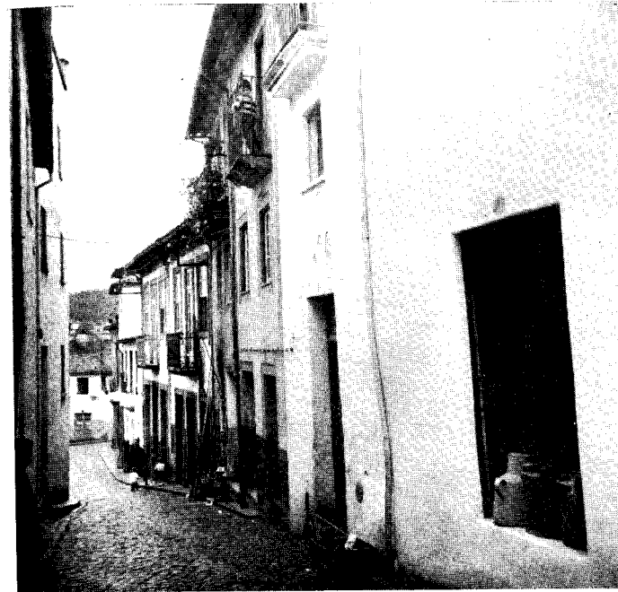
EST. V, A — Uma rua da Valeta ( Valeta de Baixo ). Repare-se no aspecto modesto das habitações e nos pequenos comércios que ocupam o rés-do-chão
