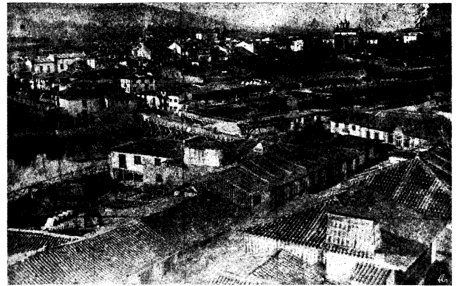
EST. II, A — A vila, vista do arrabalde da Ponte, antes da construção da actual ponte (1880). Evidencia-se o corredor de casas e azenhas que prolongam o pequeno núcleo da margem esquerda até ao terreiro; sobressaem no conjunto as torres da igreja da Lapa e Matriz e os quintais nas trazeiras das casas que delimitam a Rua Direita. (Fotografia cedida à autora nos Arcos de Valdevez).
