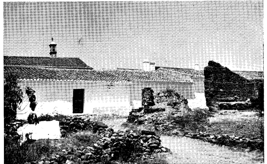
EST. IV, B — Casas de taipa; no primeiro plano vêem-se só ruínas.
