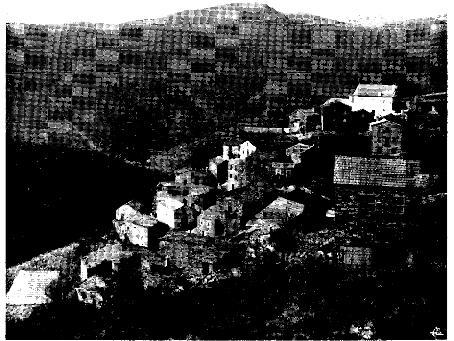
EST. XI — Vasco Esteves de Cima. Elegendo os sítios mais soalheiros, as novas construções, rebocadas e caiadas, em nada mudaram o estilo tradicional.
