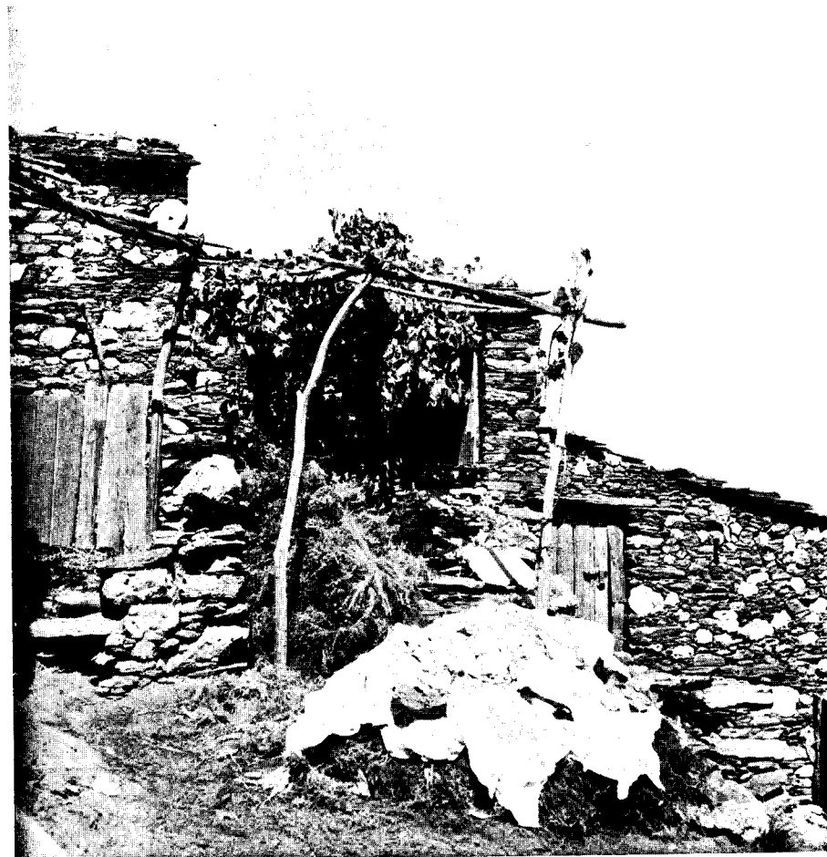
Est. VII — Aveleira . — Tipo tradicional de casa de xisto, com blocos de quartzo. Cobertura de lousa e escada exterior para o sobrado, em cujo vão se dissimula o «poleiro».
