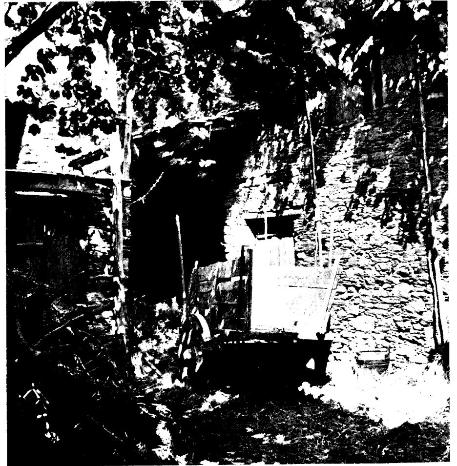
Est. VI — Lomba . — Recanto de pátio interior. Carro de bois à entrada dum forno.
