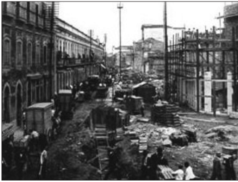
Fig. 1 – Obras na Rua da Carioca (1905).
