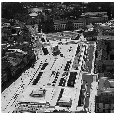
Fig. 4 – Campo da Vinha após a intervenção urbanística (orientação Oeste-Este).
