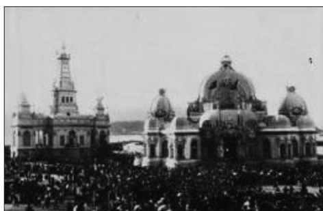
Fig. 4 – Pavilhão dos Estados de Minas Gerais (esq.) e São Paulo (dir.).
