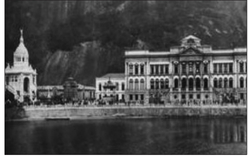
Fig. 9 – Pavilhão dos Estados e Porta Monumental.
