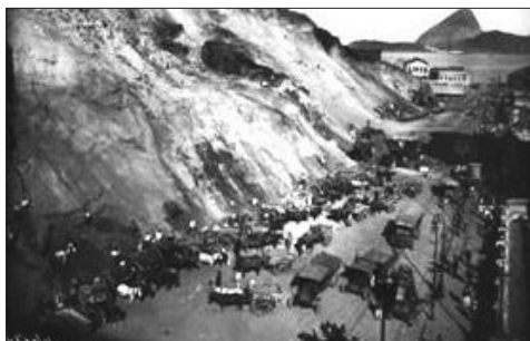
Fig. 10 – Desmorte do Morro do Castelo.
