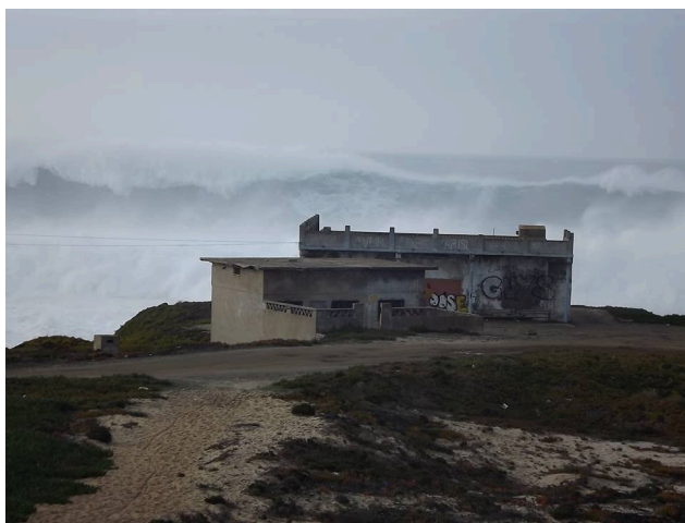
Fig. 4 – Photographie de Costa do Norte (Sines), pendant la tempête « Hercules » le 06/01/014. Figure en couleur disponible en ligne.
