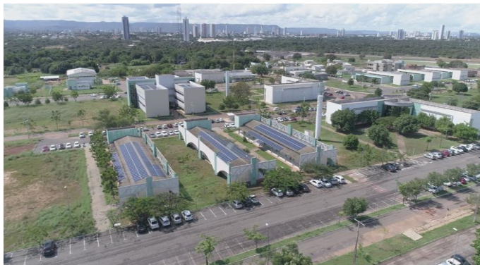
Figura 7 – Vista aérea parcial da UFT - CUP. FONTE: Audiovisual UFT, 2019.
