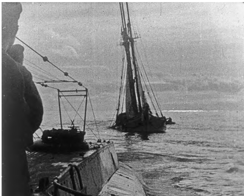
Foto 2 – O U139 aproxima-se do lugre Rio Cávado para verificar o seu afundamento
