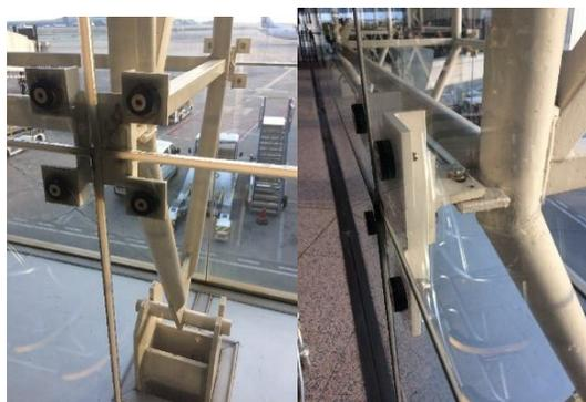
**Ilustração 5** – Exemplo de fixação de uma fachada de vidro.
