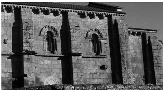
Figura 3.2 – Exemplo de aplicação de contrafortes na arquitetura românica ( http://www.lafronteradelduero.com )
