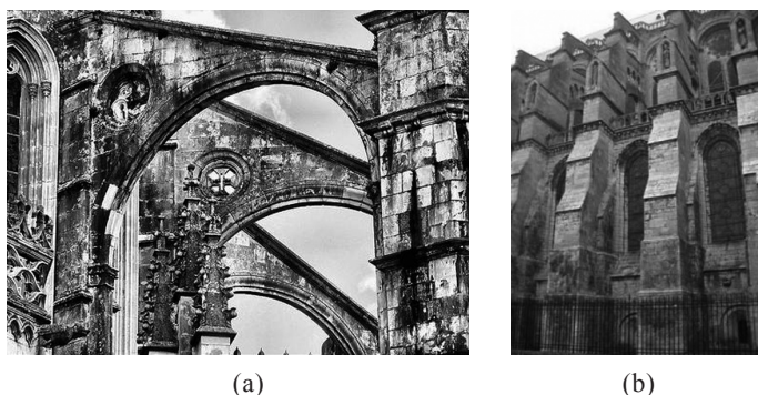
Figura 3.3 – Elementos característicos do gótico: (a) Arcobotante, mosteiro da Batalha, séc. XV ( http://www.vector99.xtreemhost.com ); (b) Abertura de vãos entre contrafortes para aproveitamento da luz natural para iluminação interior, catedral de Chartres, séc. XII (Nunes, 2009)
