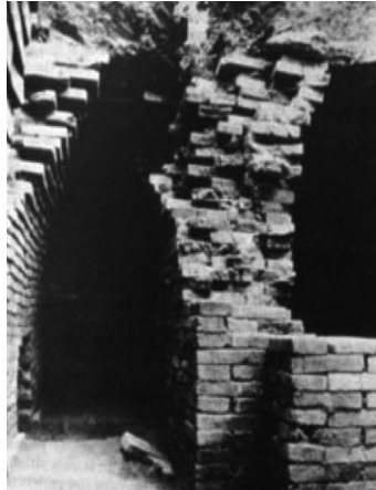
Figura 2.2 - Construção de abóbadas por fiadas avançadas, Palácio de Mari, Mesopotâmia, Séc. XXI a.C. (Churtichaga, 2001)
