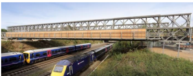
Figura 10 - Utilização de painéis sobrepostos no Reino Unido, adaptado de Mabey Bridge 2020
