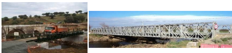
Figure 3 - Ponte Bailey instalada pela Companhia de Pontes em Ferreira do Alentejo (à esquerda) e em Odemira (à direita) (Pereira, 2015) (André, 2016).
