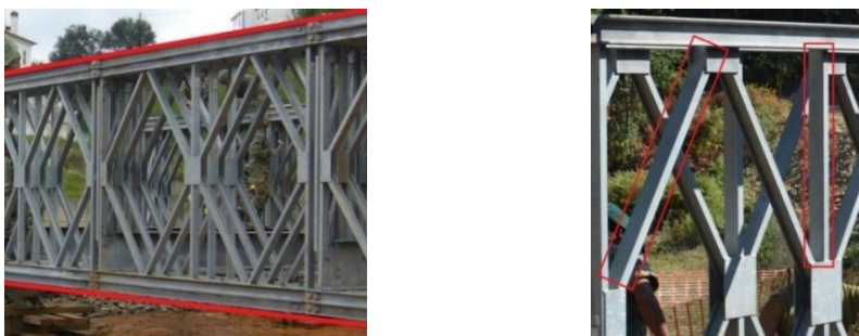
Figura 11 - a) Reforço das diagonais e b) Reforço das cordas
