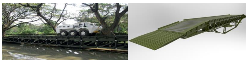
Figura 2 - Da esquerda para a direita: Ponte MGB montada e a ser utilizada; Modelo informático da Ponte MGB (WFEL, 2011)
