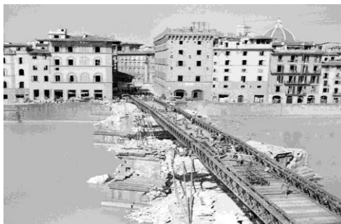
Figura 2 - Ponte Bailey a substituir ponte destruída em Florença, adaptado de ThinkDefence (2012)
