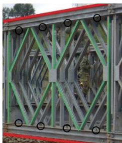
Figura 12 - Reforços/alterações representadas num painel-tipo
