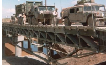
Figura 3 - Ponte MGB com configuração dupla com reforço, adaptado de ThinkDefence (2012)
