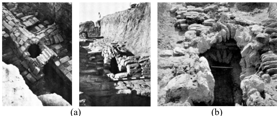
Ilustração 9: Aplicação do princípio do arco em túmulos: (a) Sistema de esgoto abobadado sob o Palácio Norte, Tell Asmar (período acadiano); (b) Dreno abobado de tijolo em Cafaja (antiga Tutube), Mesopotâmia (4000-2500 a.C.).
