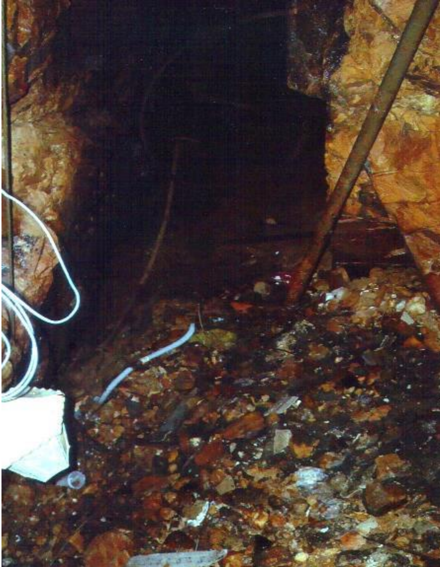
Figura 3. Entulhamento. Fonte: Paula Resende.
