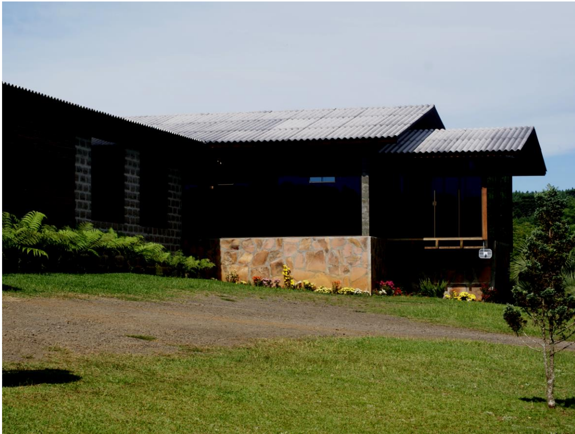
Figura 3. Cantina da vinícola Villaggio Grando.
