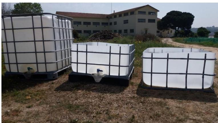
Figura 2: Construção dos leitos a partir de tanque de 1m<sup>3</sup>
