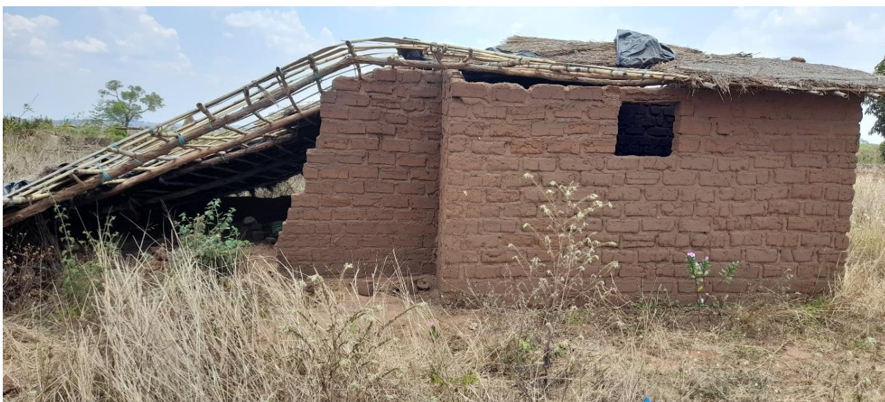
Figura 1 Tipos de casas (palhotas ) predominantes em Tambara, construídas de estacas ou bloco cru.
