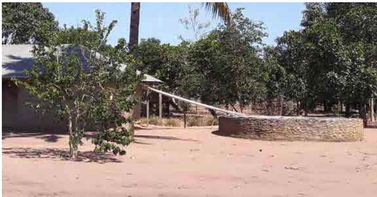
Figura 3 Uso de sistema de colecta de água pluvial, cabo delgado.
