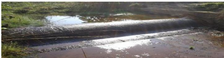
Figura 2: Barragem de nível no rio Muda, para abastecimento de água na vila municipal do distrito de Gondola.
