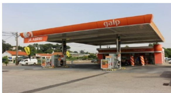
Figura 3: Bombas de Combustível de Chiango
